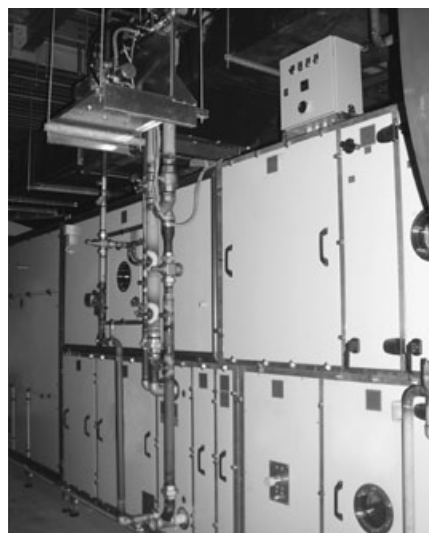
Система насосов высокого давления
